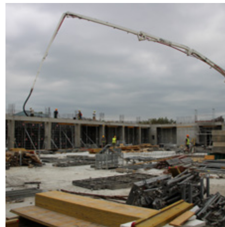
Fot. Budowa sali sportowej (stan na 27.06.2019 r.)
