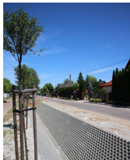
Fot. Remont ul. Przylesie
